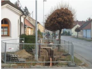
Im Herbst wurde mit der Erneuerung der Gasleitung und Verlegen der Stromleitung in der Poysdorferstraße begonnen. Vereinbart wurde, dass, wenn im Gehsteigbereich gegraben wird, die Betonfelder zur Gänze herausgenommen werden und der Unterbau durch die EVN herzustellen ist. Im kommenden Jahr erfolgt die Wiederherstellung durch die Gemeinde.
